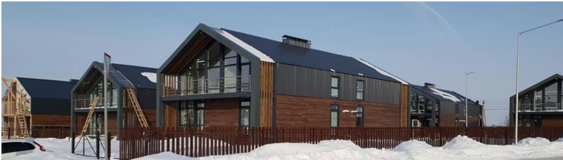
Строительстве энергоэффективного домов ДОН в Самаре
