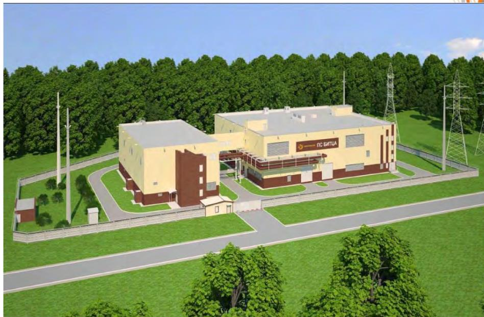
В результате реконструкции образуется резерв мощности для технологического присоединения потребителей на уровне напряжения 20 кВ в размере 195 МВт, на уровне напряжения 10 кВ — 35 МВт.
