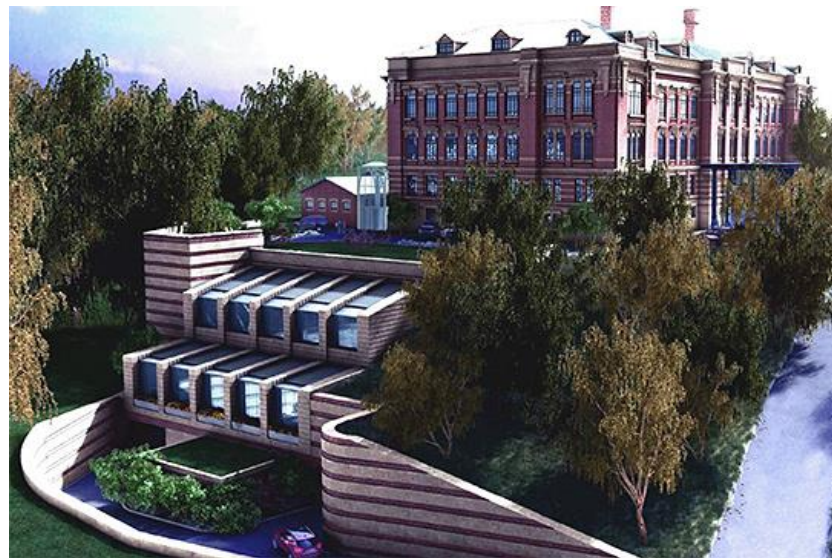
Отель TASIGO – реконструкция Шамовской больницы
